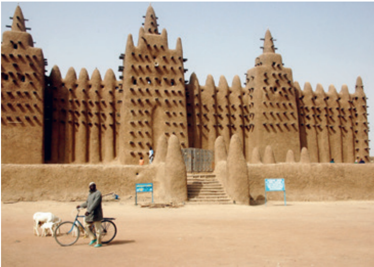
Einige Praktiken, die mit dem lebendigen Erbe in Verbindung stehen, wurden teilweise oder vollständig unterbrochen, wie z.B. das Wissen der Gemeinschaft über die Erhaltung des architektonischen Erbes aus Ton in Djenné, Mali.
